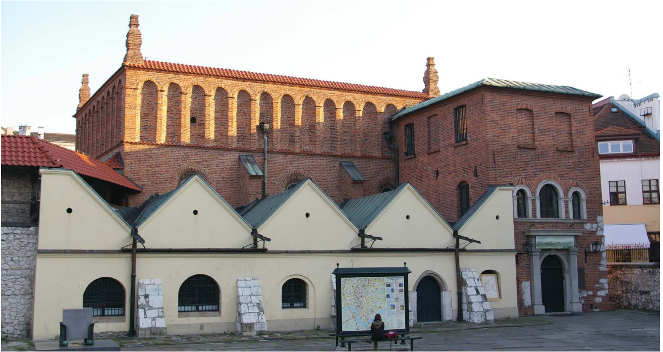
Alte Synagoge in Kazimierz, Außenansicht, Krakau 2014.
